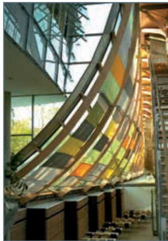
Bureaux Landshut - Allemagne
